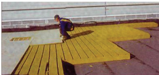
4 pav. Įrengiama termoizoliacinė ventiliuojama konstrukcija [7].
