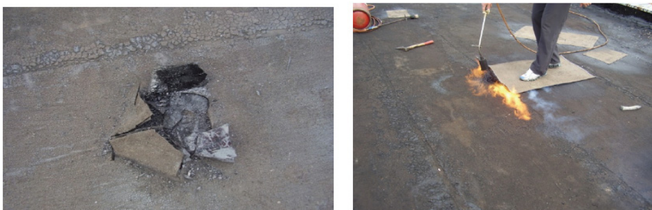
3 pav. Iškerpamos pūslės stogo dangoje ir išgarinama drėgmė kaitinant degikliu [7].
