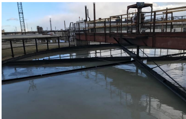
5 pav. Flotacijos įrenginys skirtas iš I ir II sistemos nuotekų valyti emulguotos naftos produktus
