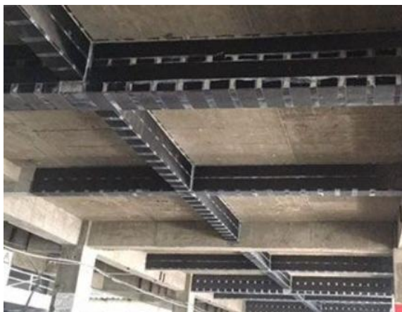
2 pav. Anglies pluošto kompozitų pavyzdys (Rajak, Pagar, Menezes ir Linul, 2019)
